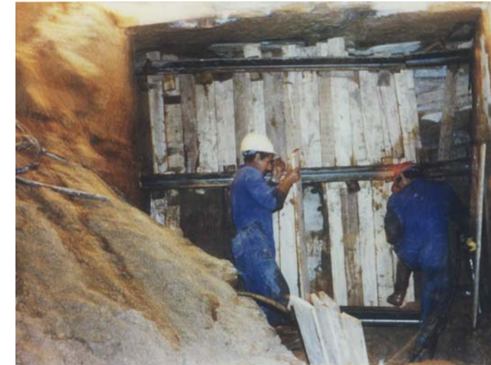
Figura 6.- Entibación de batache.
