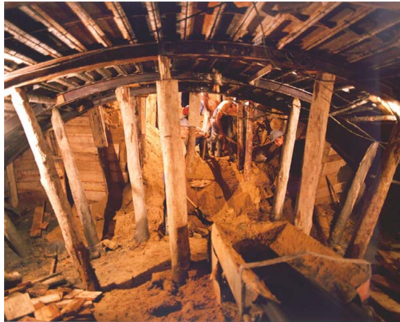
Figura 2.- Ejecución de la bóveda.
