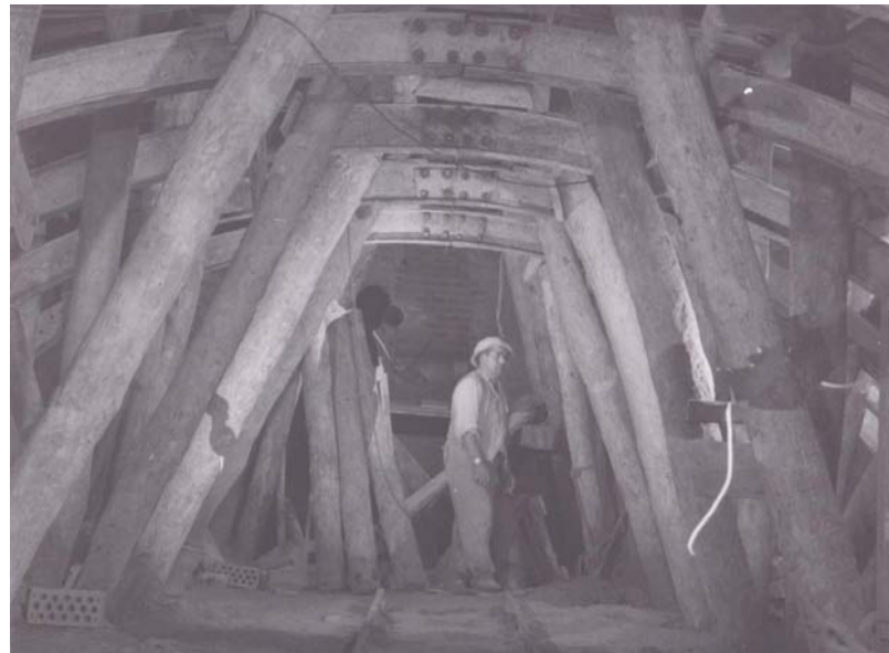
Figura 4.- Entibación total realizada con madera.
