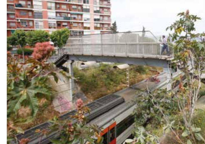
▶ L'obra complementa el projecte de remodelació integral de la plaça de la Salut que es va iniciar al febrer.
